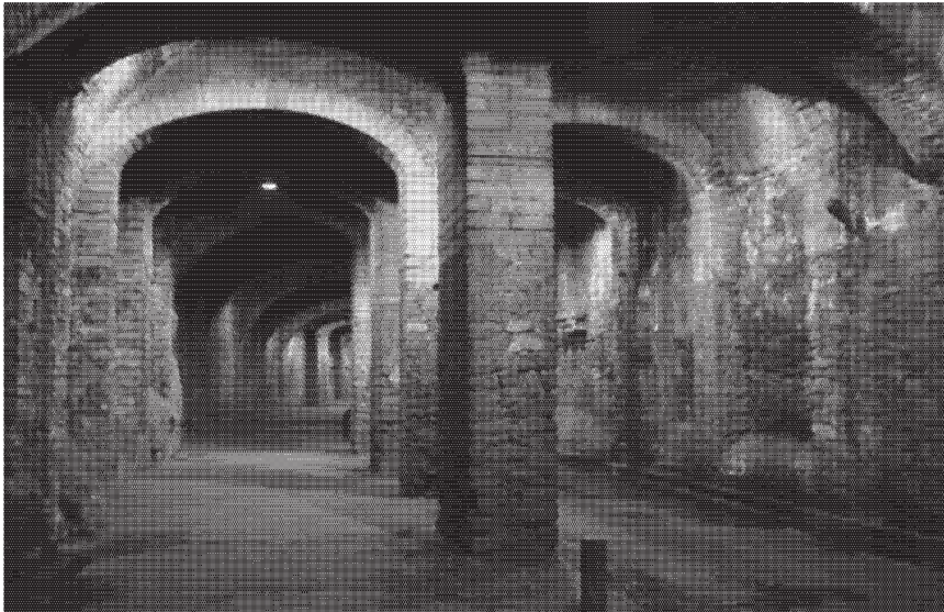
GRÁFICO 23. ILUMINACIÓN AL INTERIOR DE LA CALLE SUBTERRÁNEA
